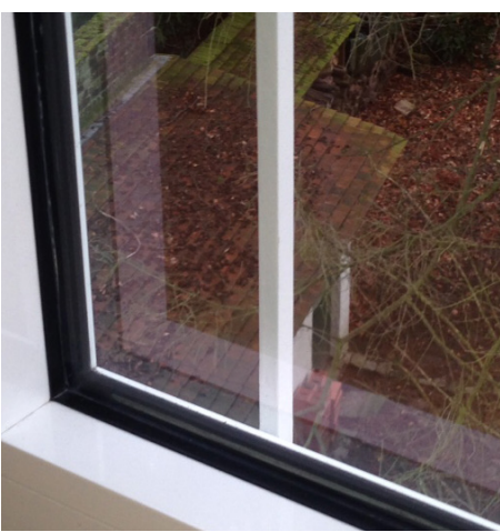
Matzwarte Warm-Edge Spacer valt niet op in tegenstelling tot de aluminium afstandhouder
